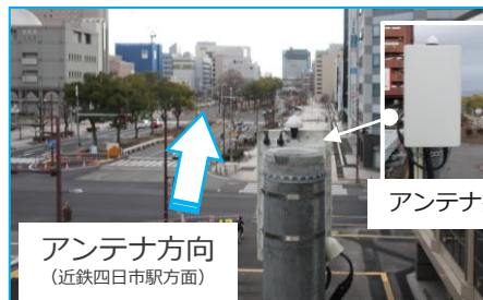
施工後 (アンテナ拡大)
