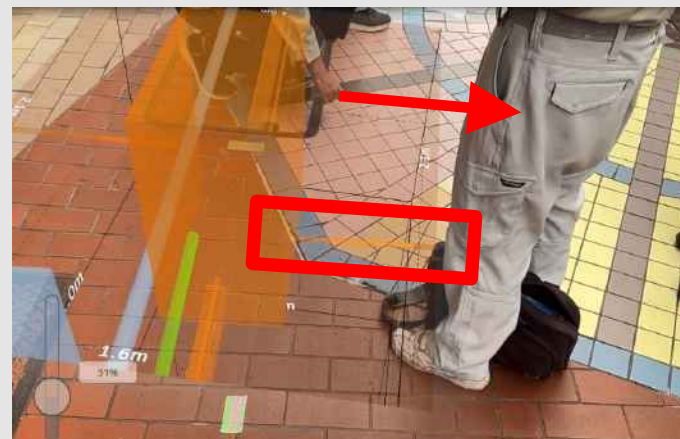
【埋設管位置マーキング】
